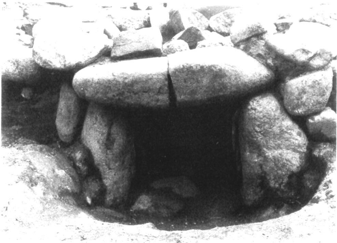
SF 1 蒸風呂（焚口付近）
